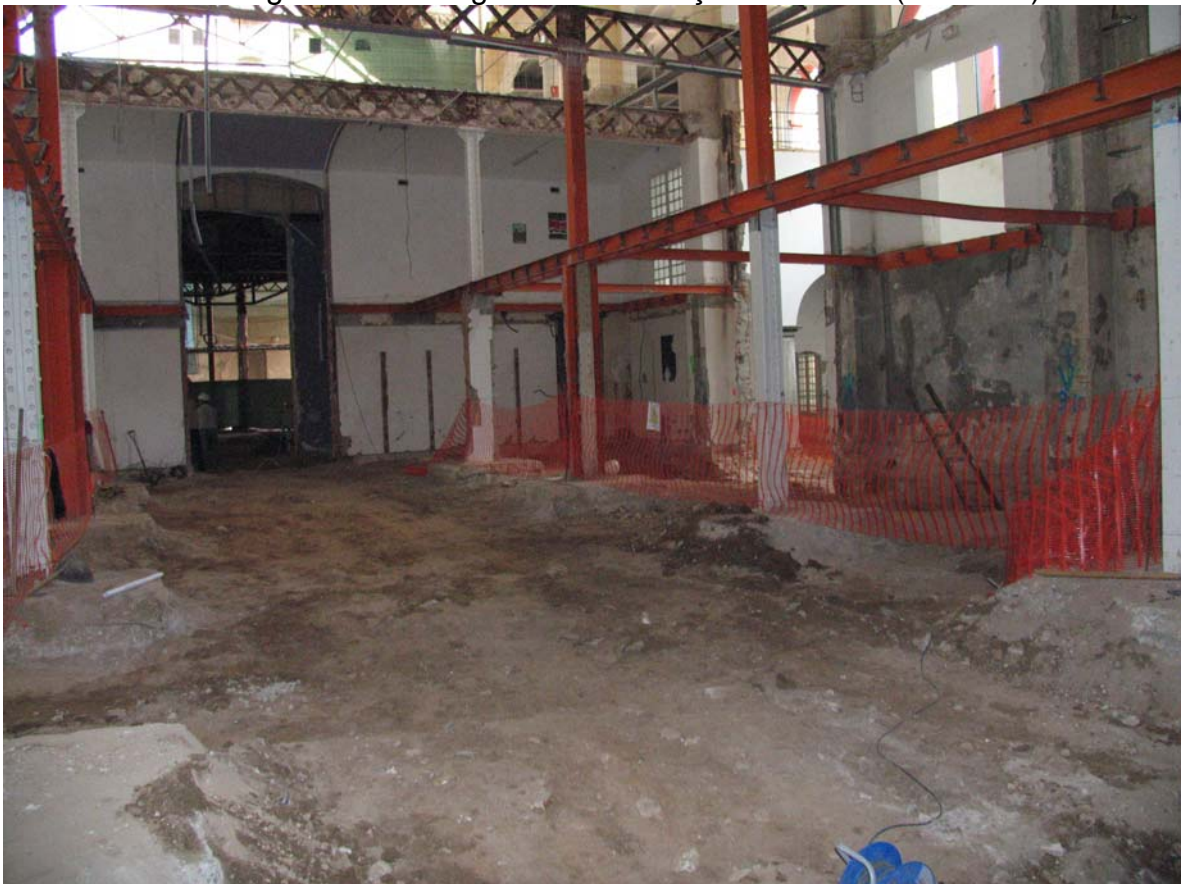
Fotografia 2. Vista general del sector A. (102/08-203)
