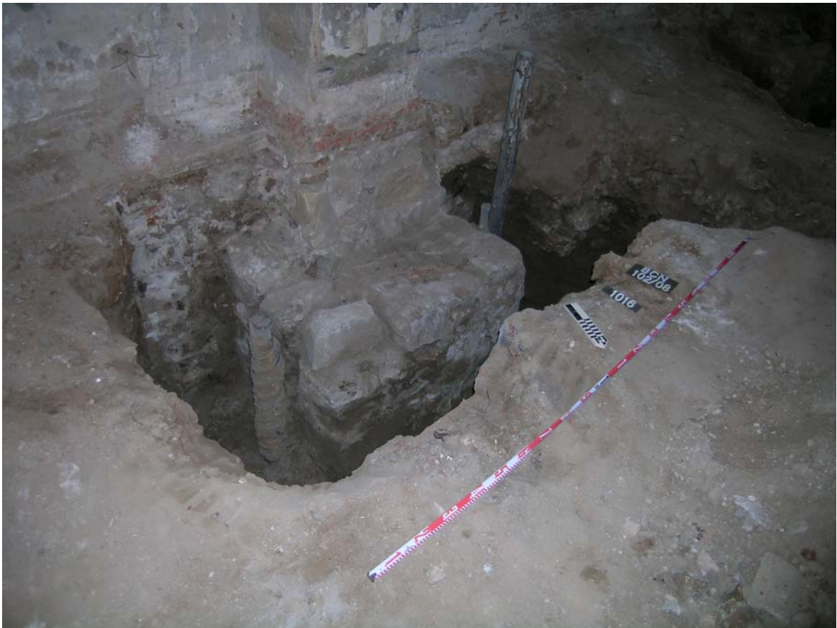
Fotografia 3. Treballs de micropilotatge, UE 1016. (102/08-45)
