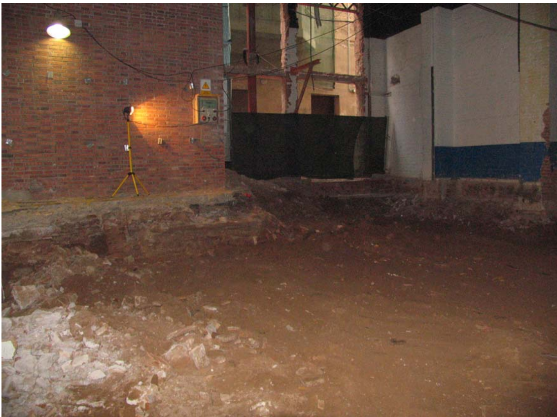
Fotografia 16. Vista general del sector B al nivell final. (102/08-480)
