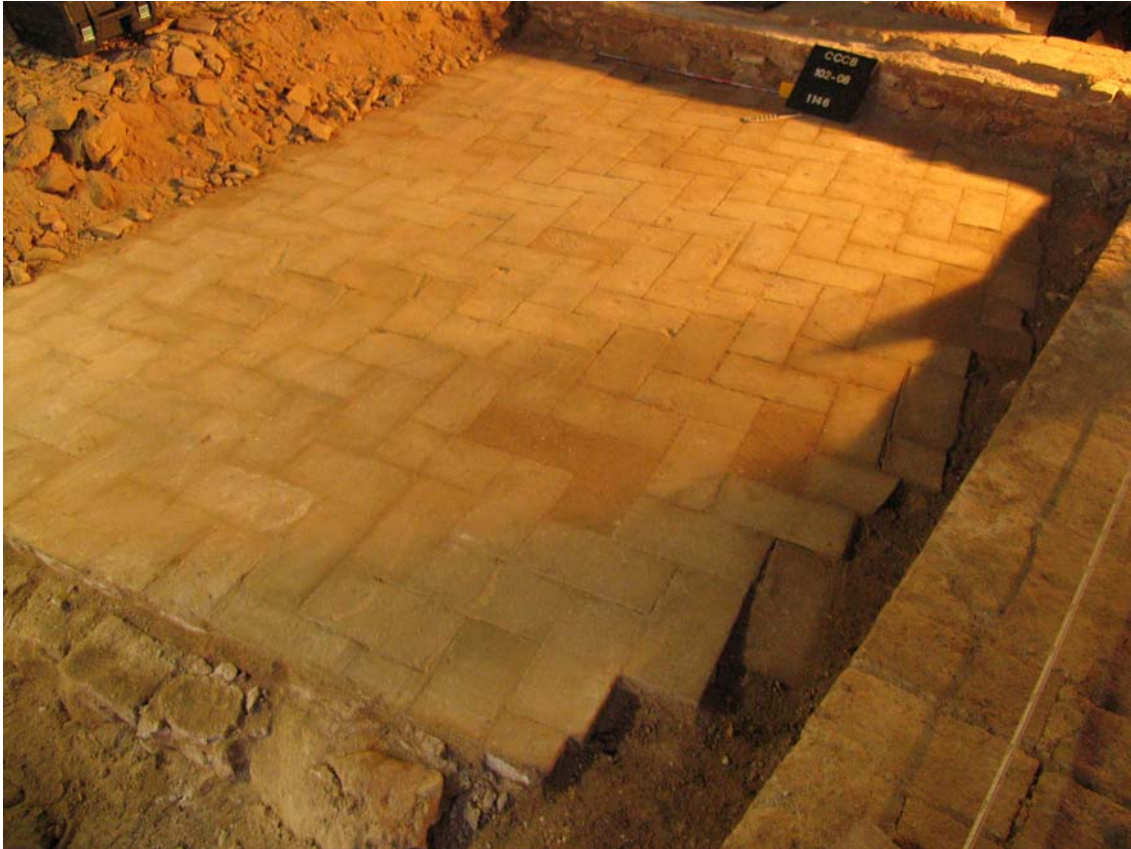
Fotografía 13. Vista parcial del pavimento 1146. (102/08-340)
