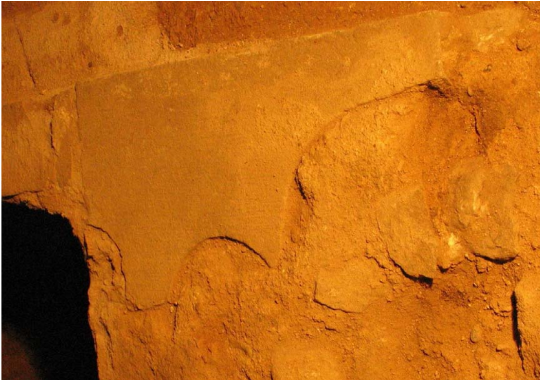
Detall de la finestra reaprofitada al mur.
