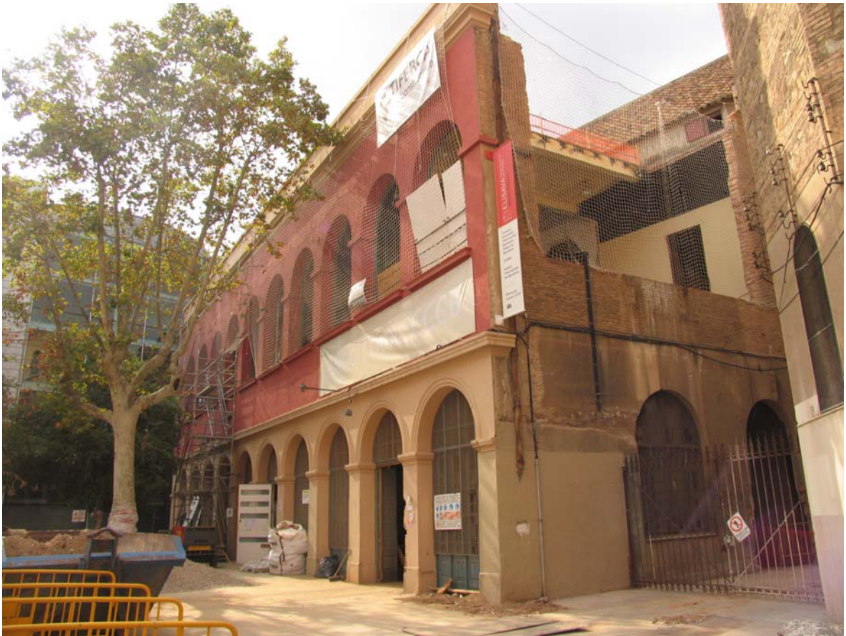
Fotografia 1. Vista general de la façana exterior. (102/08-1)
